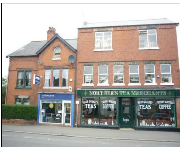
Nos. 193-197 Chatsworth Road
